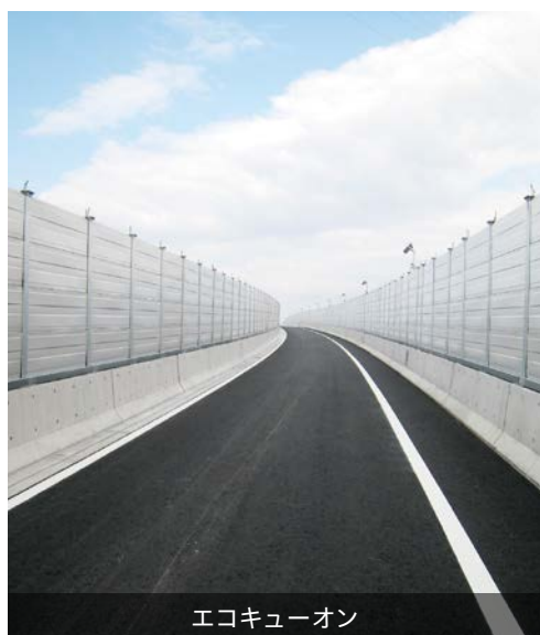
透光性遮音板 アクリル透光パネル
