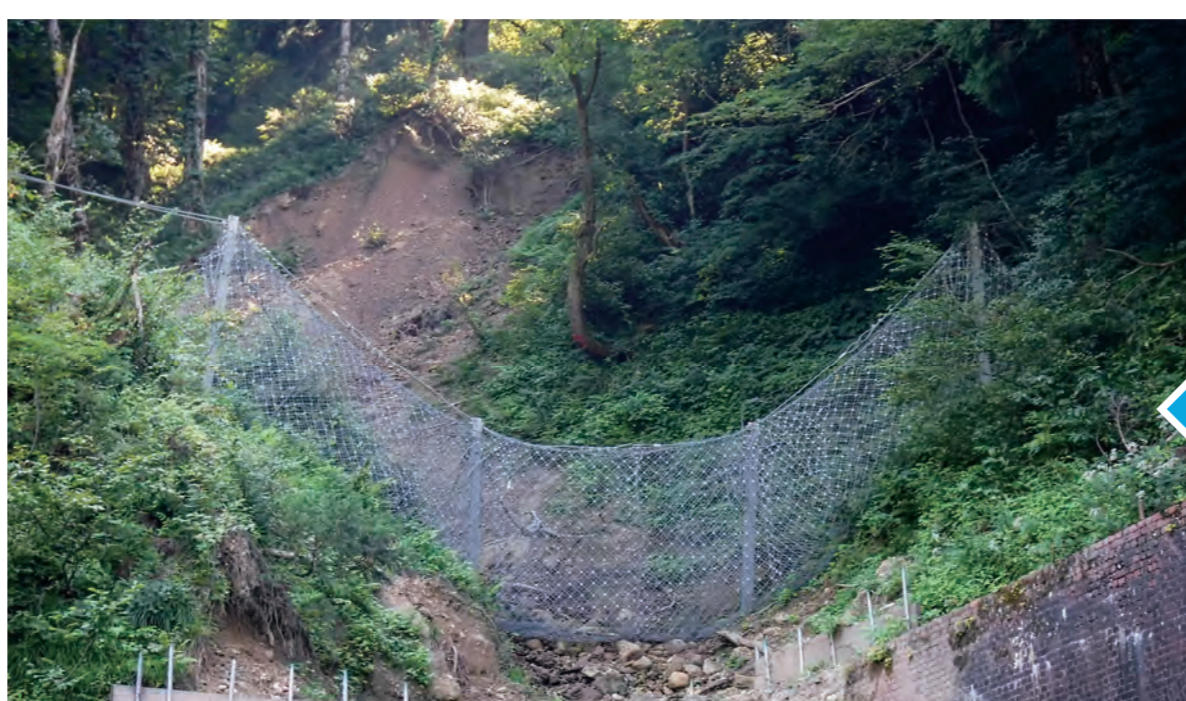
切断したネットを補修 → 再度捕捉を確認
