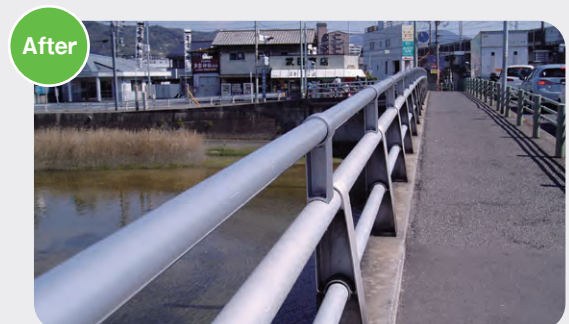
府中大橋 (広島県)
