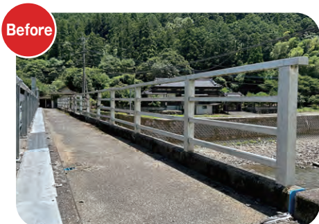
吉尾橋側道橋 (熊本県)
