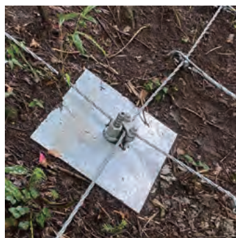
自穿孔アンカー用 アンカークリップ
