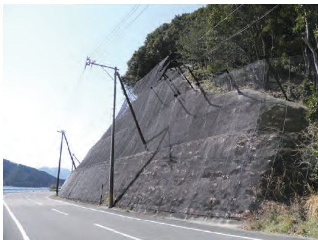
ポケット式落石防止網
