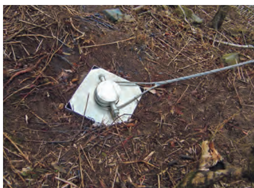
土中用 B アンカー(中間部) さや管付パイプアンカー
