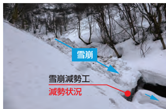
全層雪崩の流れを防止した状況
