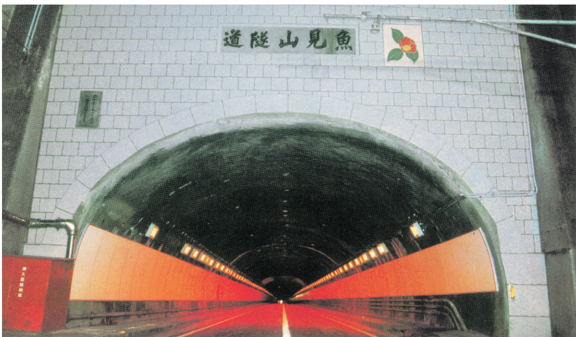
国道31号線魚見山トンネル補修工事
