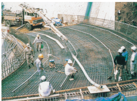
大阪府川尻3号橋床版新設工事
