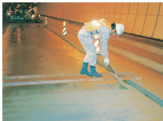
NEXCO 今庄トンネル内舗装改良工事
