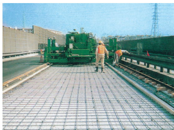
NEXCO新滝川橋補強工事
