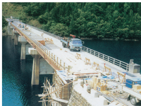
福井県林谷橋橋梁床版補修工事
