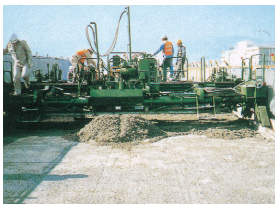
NEXCO荒牧高架橋RC中空床版補強工事
