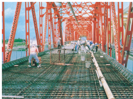
福岡県六五郎橋床版改修工事
