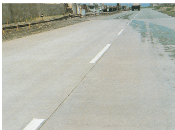
神鋼加古川製鉄所構内道路舗装
