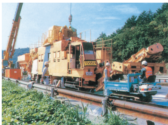
NEXCO東名高速道路佐野川橋床版改良工事
