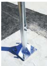
2 端末支柱、端末金具をアンカーボルトに固定します。
