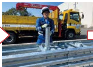
差込管引抜き、回転
