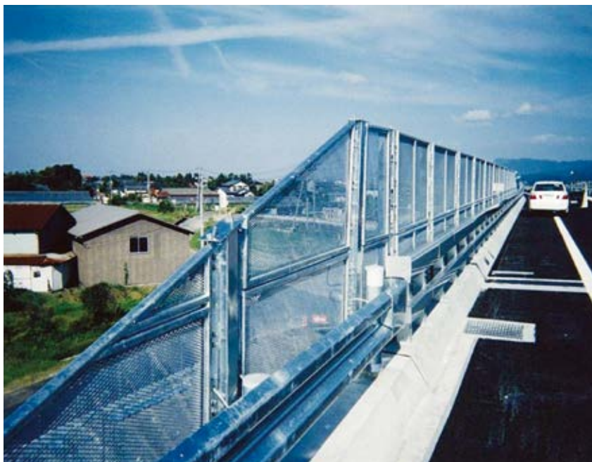
※ガードレール付飛雪防止柵（エキスパンドパネルタイプ）
