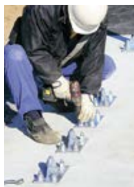
2 端末支柱、端末金具をアンカーボルトに固定します。
