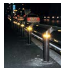
夜間撮影(国道6号)
