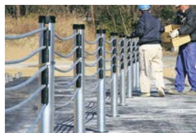
6 ワイヤロープ、間隔材、ストラップをセットし、キャップを取り付けます。
