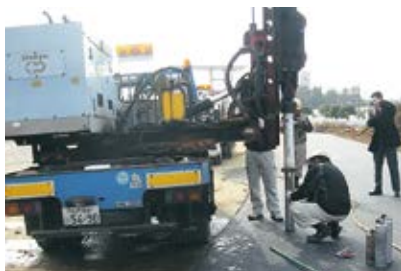
1 アスファルトをコア抜き、エアースライカーによりスリーブを打込みます。
