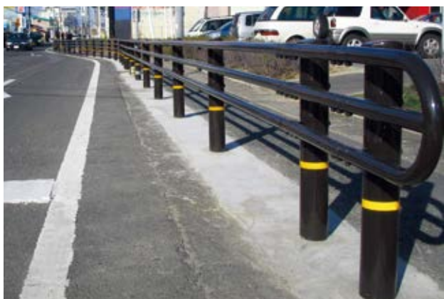
端部処理施工例
