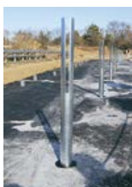
5 スリーブに中間支柱を挿入し、スリーブカバーをセットします。
