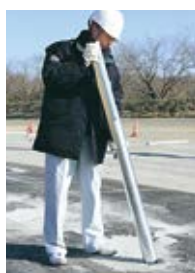
5 スリーブに中間支柱を挿入し、スリーブカバーをセットします。
