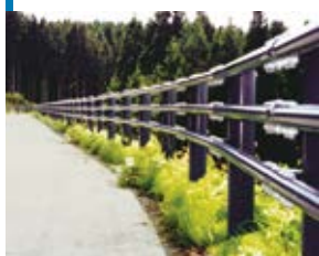
ガードパイプ
