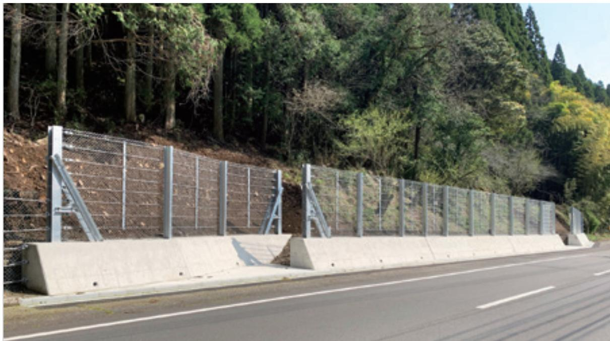
落石防止柵は、比較的小規模な落石対策として使用できます。
