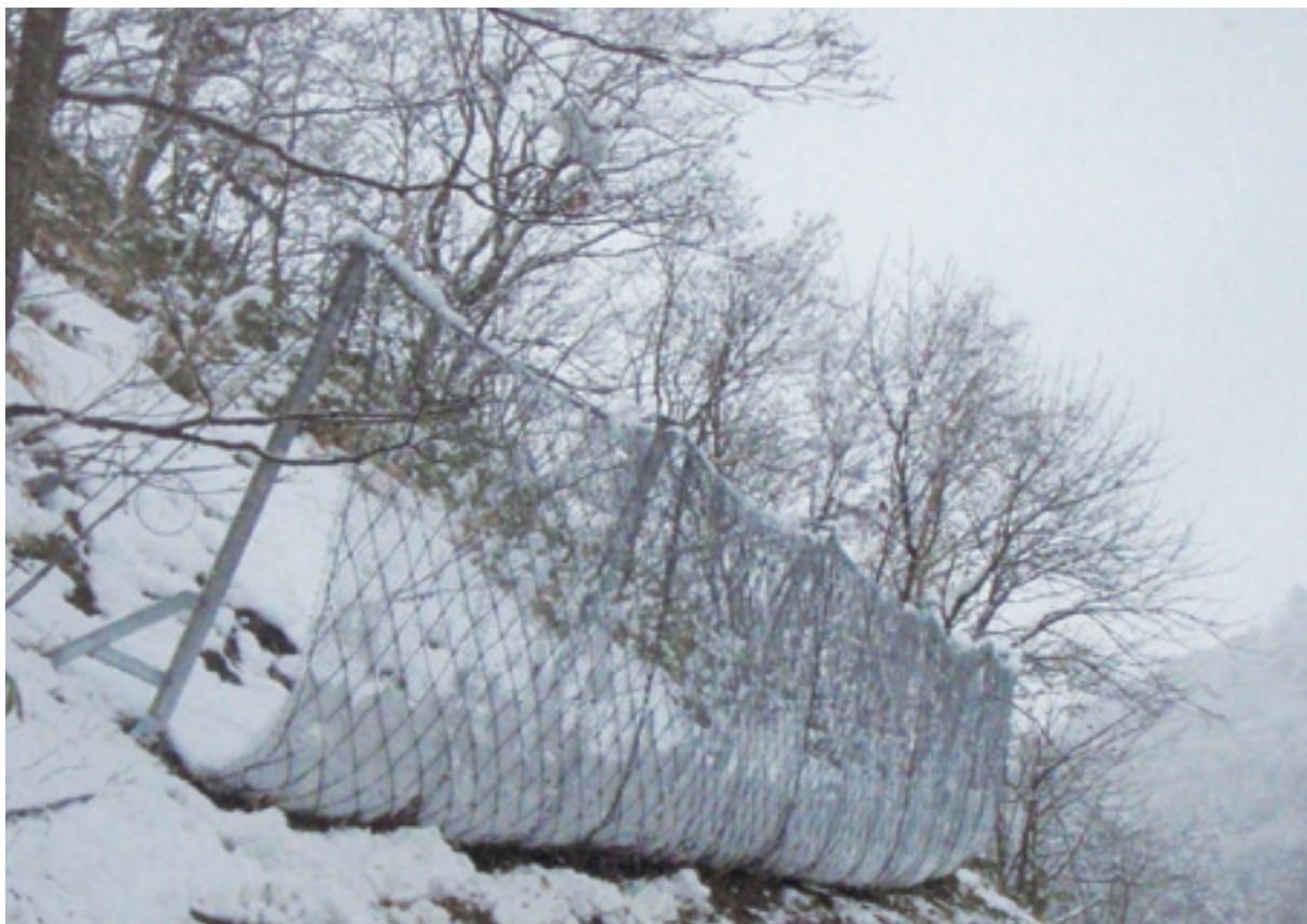
ハイジュールネットが積雪地方に設置された場合、斜面からの雪圧を直接受けることとなります。柔軟な構造のため、雪荷重に対してどのような挙動を示すか、実際に実験を行い、積雪荷重で落石捕捉機能が損なわれないよう補強を施した積雪対応型ハイジュールネットを開発しました。
