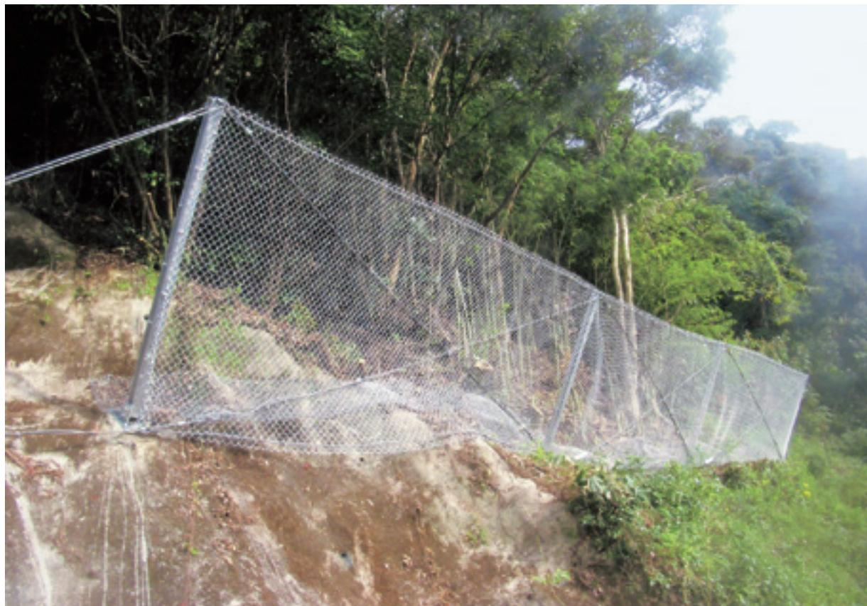
ロックホールド100は、50～200kJまでの落石エネルギーを捕捉できる落石防止柵です。50kJ・100kJ・200kJの3つのバリエーションで設置条件に最適な型式を選択できます。小規模な伐採での施工が可能なことから、地山の改変を必要とせず、自然の景観と環境と守ります。また、工期の短縮がはかれ、コストパフォーマンスに優れています。
