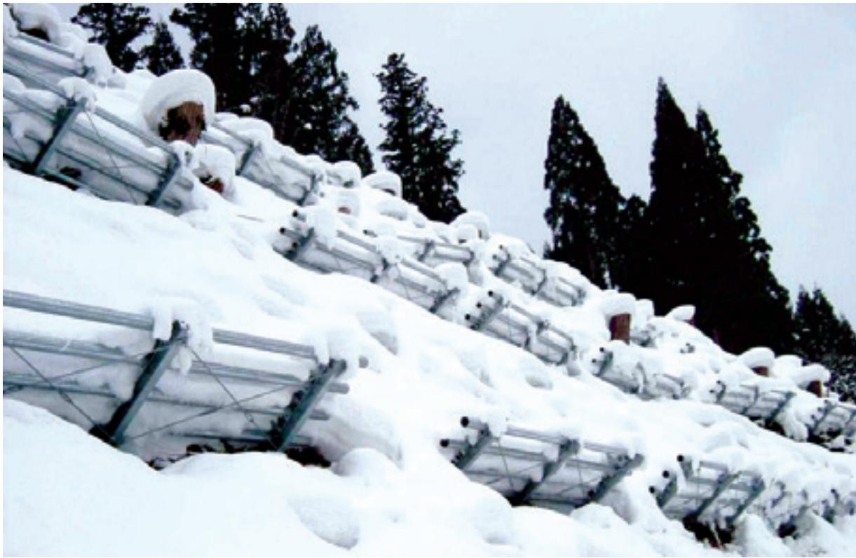
雪崩予防柵は雪崩を未然に防ぐための施設です。傾斜地の地盤に直接支持させる固定柵型のほか、自然斜面や急傾斜で基礎の根掘りが困難な場合に適した吊柵型があります。
