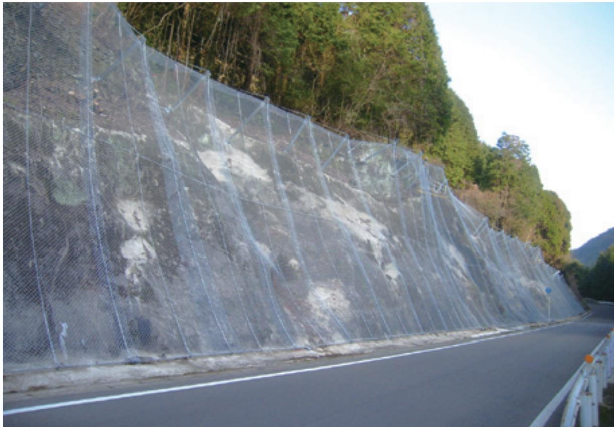
覆式落石防止網は、地山の結合力を失った岩石を金網と地山の摩擦および金網の張力によって結束するもので、落石予防工に準じた機能を持つものです。
