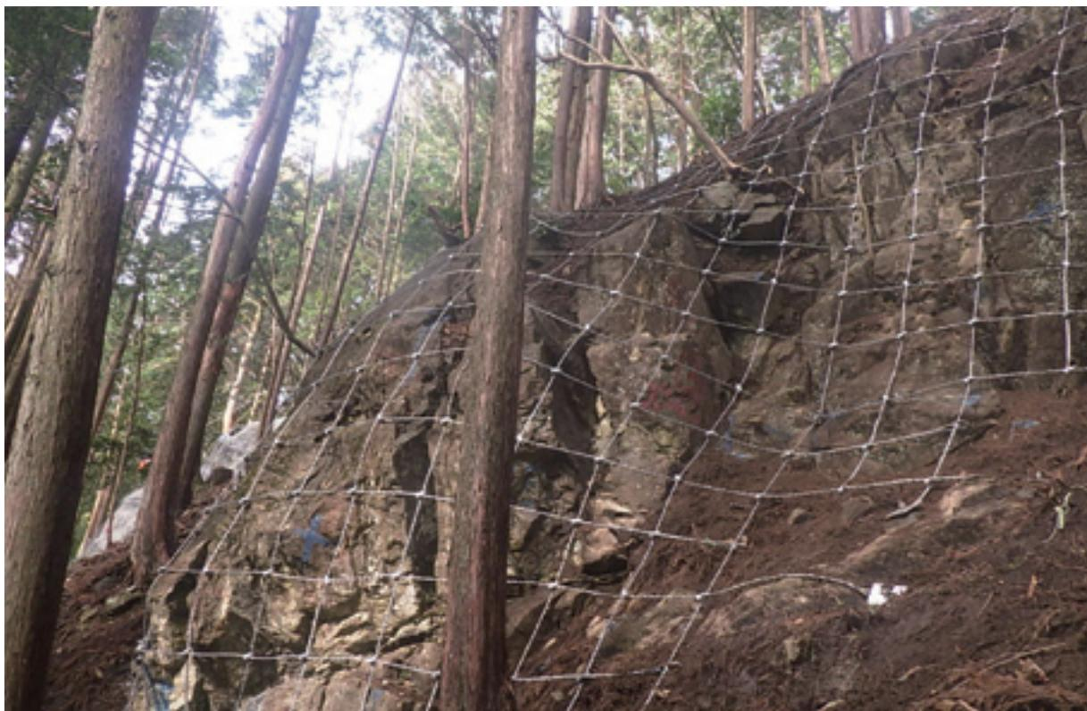
斜面に散在する浮石や転石が滑動や転動しないよう、格子状に組んだワイヤロープで浮石や転石を覆い、斜面上に固定させるものです。ワイヤロープの間隔を狭めることで、様々な浮石や、転石を固定することも可能です。
