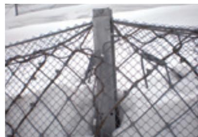
ひし形金網への変形状況
