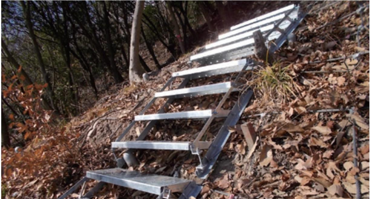
斜面避難階段工「MCステップ」は、津波襲来前に自然斜面を登って避難する時の助けとして、開発した製品です。非常時に活用することを考慮して、山間部の階段と同様に、階段の踏みしろと蹴上高は、自然斜面の勾配に応じて変化させる構造としており、大規模な切盛土や擁壁構造物は必要としないことから、経済性に優れており、多くの箇所への設置を可能としています。
