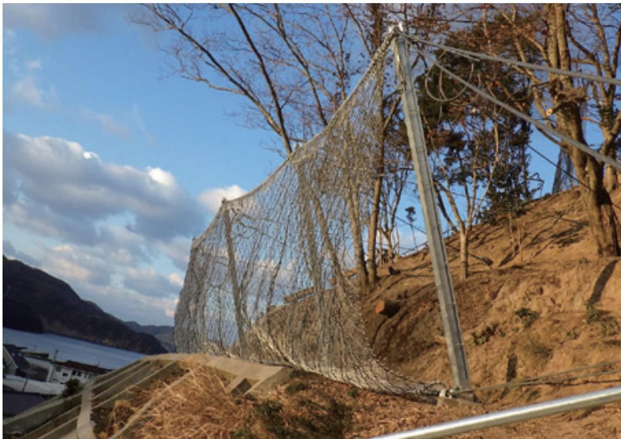
近年多発している崩壊土砂による災害を防止するため、ハイジュールネットの落石捕捉システムを応用して、崩壊土砂対応型ハイジュールネットを開発しました。
