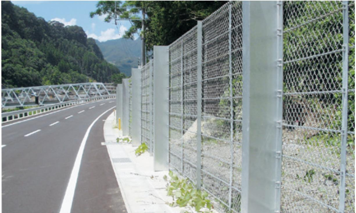
従来型落石防止柵に対して支柱の変形を抑える為、支柱を強化。
