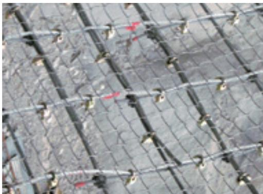
切断したネットを補修した状況
