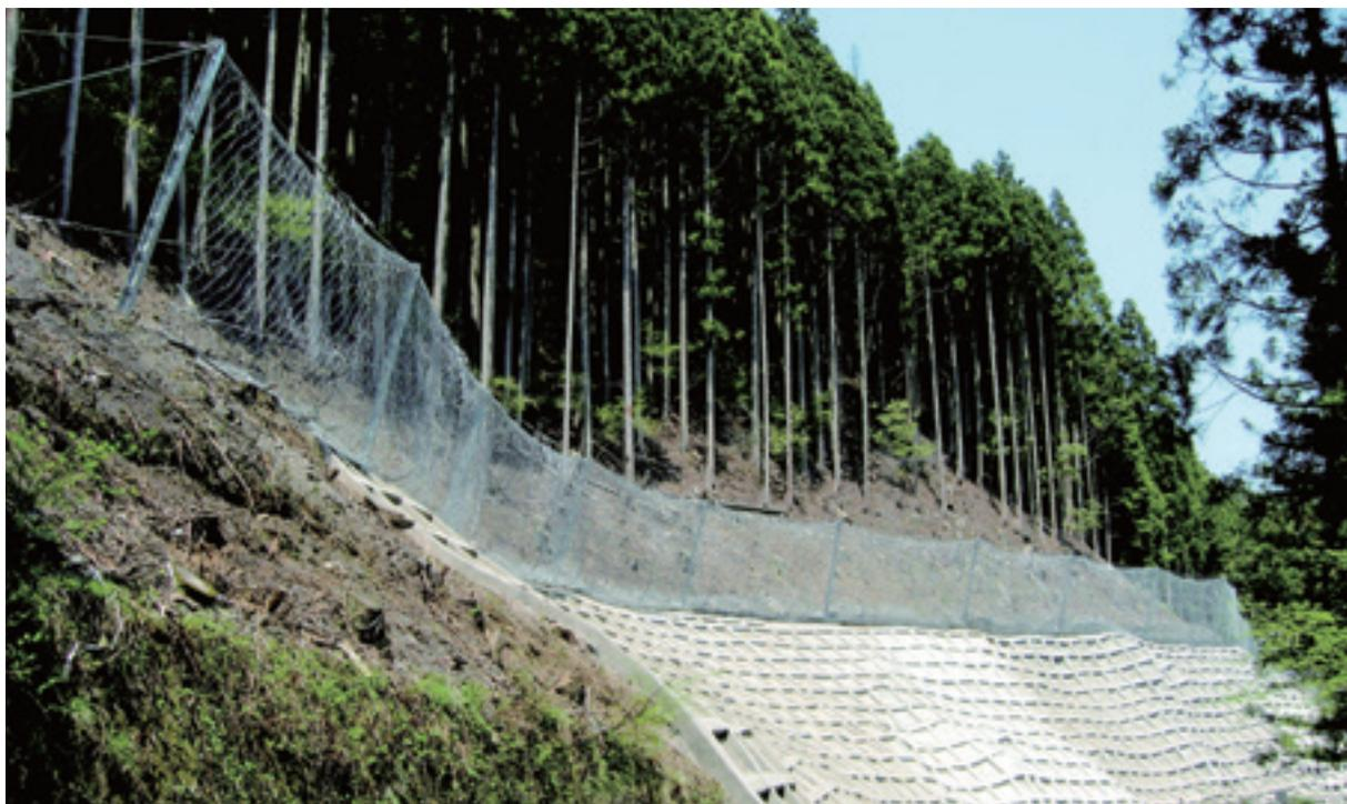
1. 支柱間隔5m～10mで、所定の落石エネルギーの吸収が可能であること。
