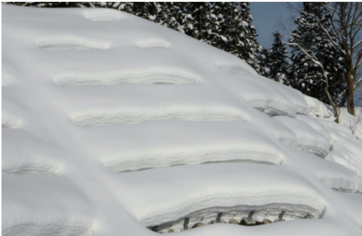
グライド抑止柵は、人工斜面の積雪層内に支柱と梁材を埋没させることで、斜面積雪層が斜面に沿って下方にずれる現象（グライド）を屋根の雪止めのように抑制する工法です。雪庇（せっぴ）の除去作業が不要で、コンクリート基礎も不要な為、従来技術である雪崩予防柵と比べ、経済性、安全性、施工性等の向上が期待できます。
