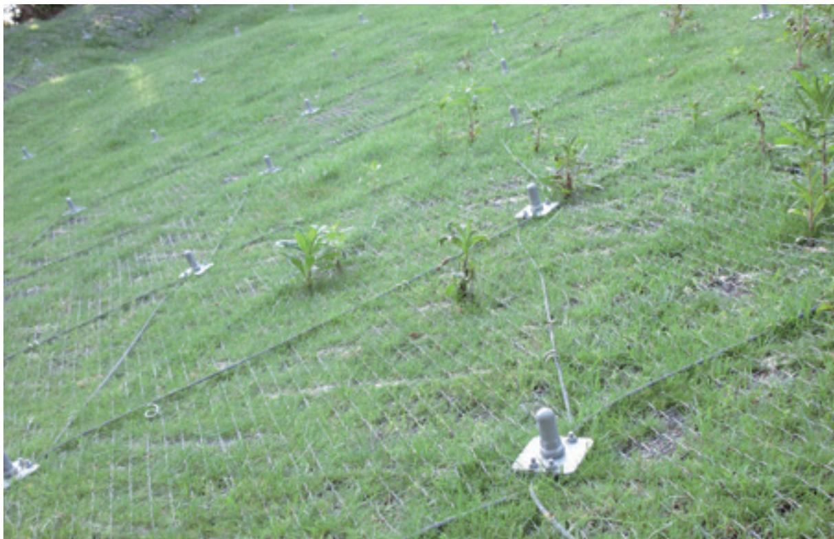
DC(Displacement Control)ネット工法は、所定のピッチで配置された補強材(ロックボルト)、斜面全面に敷設したエクシードネット(高強度金網)、ロックボルト頭部をつなぐケーブルの3構成からなる、斜面の表層崩壊と補強材間の中抜け崩壊を防止する地山補強土工法です。
