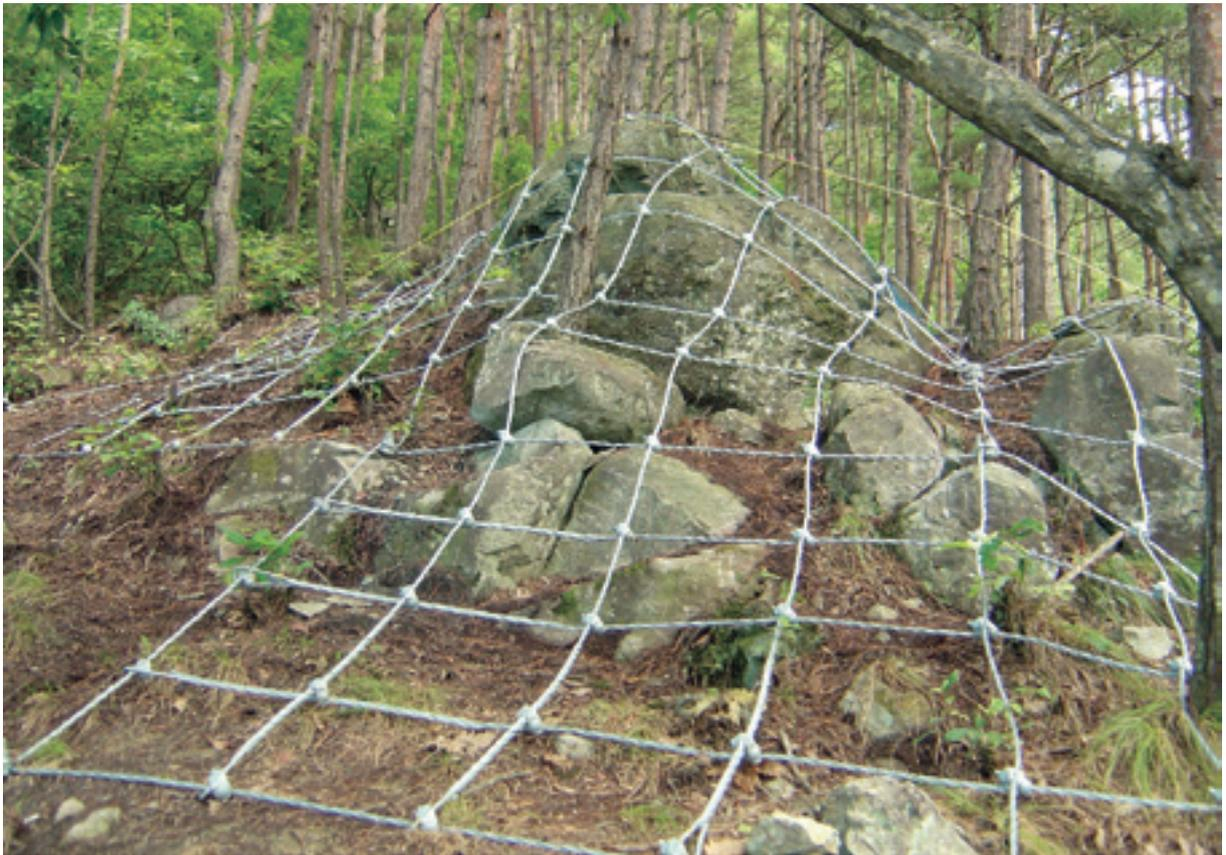
ケーブルネットは、ワイヤロープを格子状に組み、各交点をアンカーで押えることにより、浮石や転石の初期移動を抑える落石予防工です。
