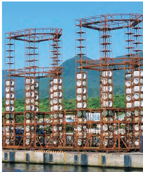
kk-21-C 転倒対策強化 (H21m×WL16m)
