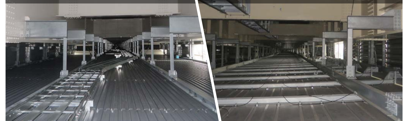
完成後に点検足場として機能する裏面吸音板の内部 (左:ルーバータイプ 右:パネルタイプ)
