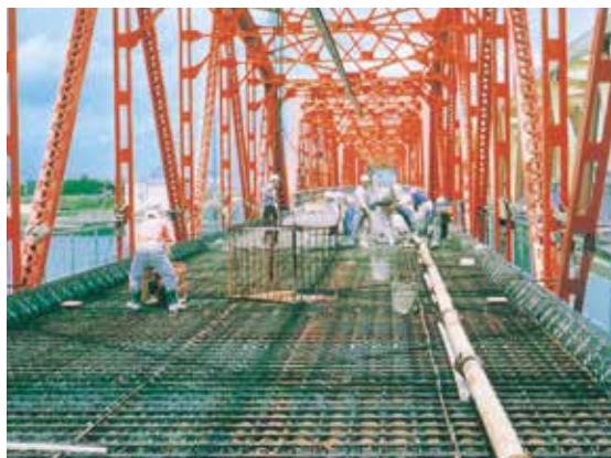
福岡県六五郎橋床版改修工事
