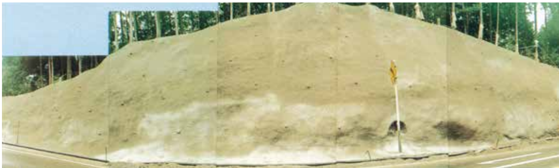
三重県国道165号線法面吹付け
