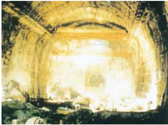
東京電力今市水力発電トンネル
