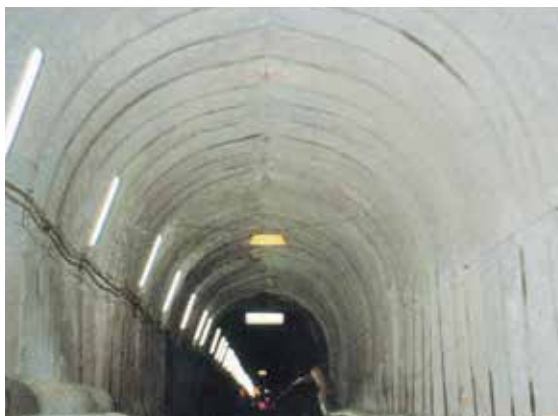
甲府市湯村山隊道配水池構造工事
