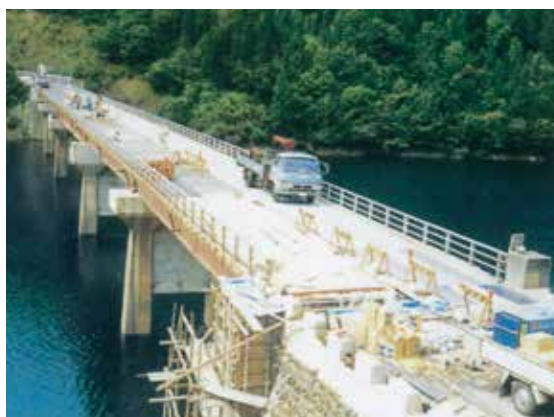
福井県林谷橋橋梁床版補修工事
