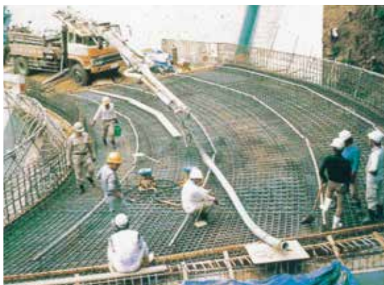
大阪府川尻3号橋床版新設工事
