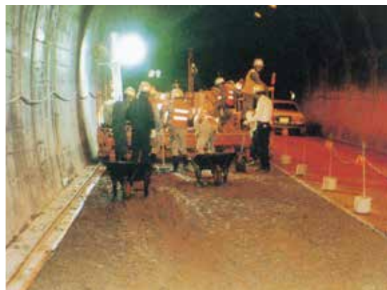
建設省倶利伽藍トンネル内舗装修繕工事
