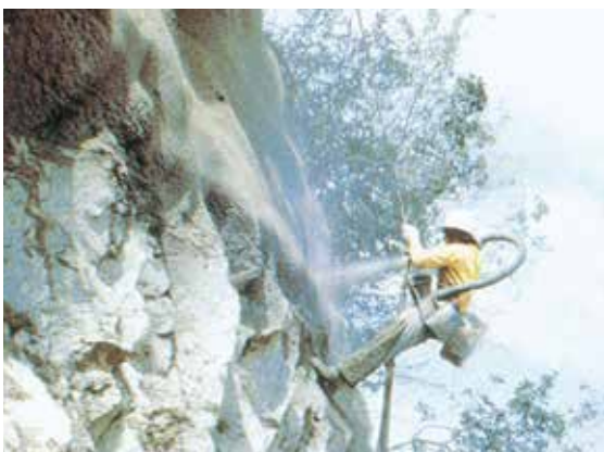
兵庫県西新宿上郡線法面吹付け
