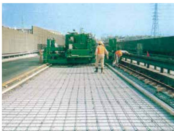
日本道路公団新滝川橋補強工事
