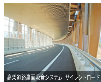
透光性遮音板 ガラス透光パネル(LITE WIND®)
