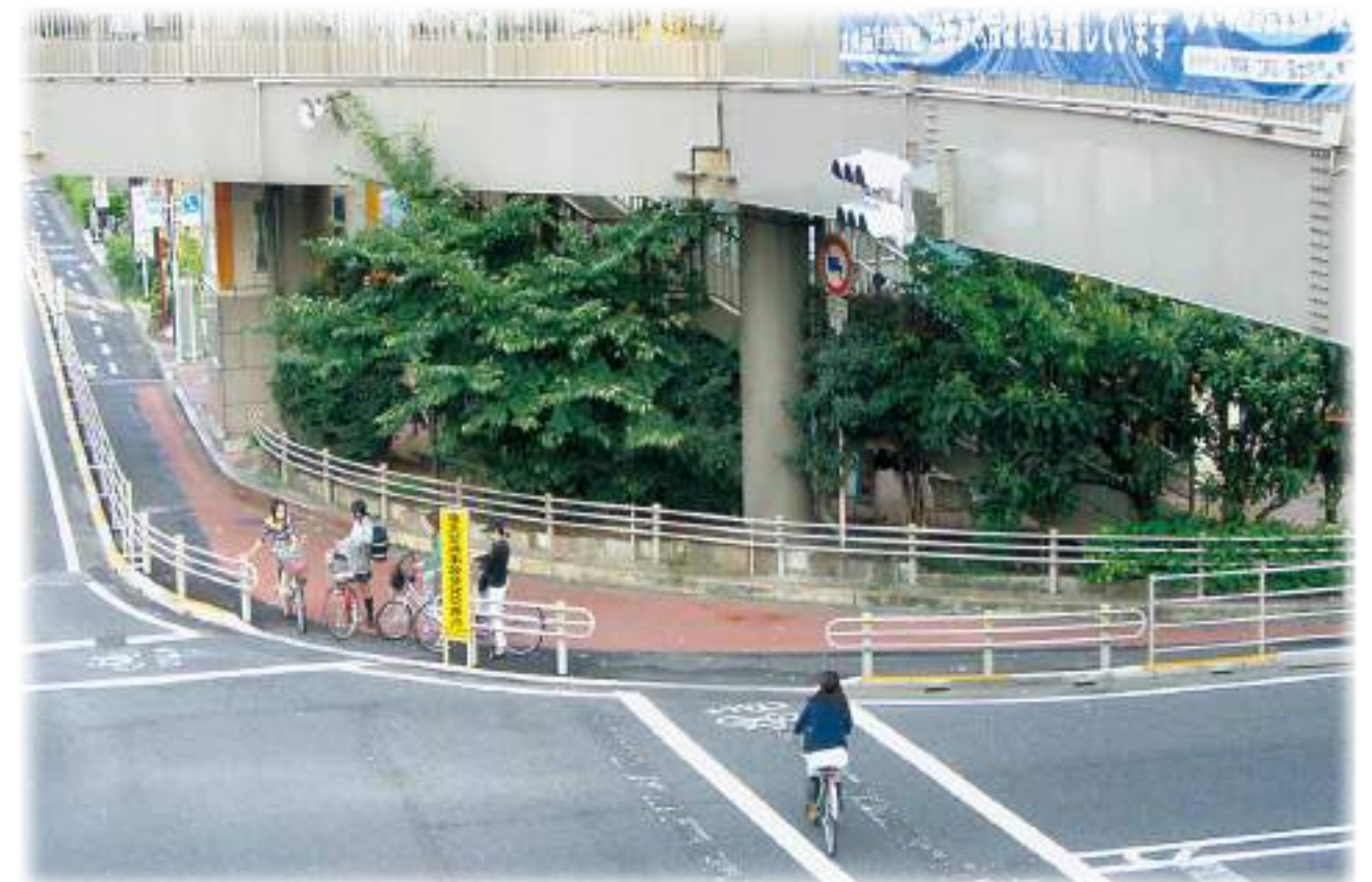
車両防護柵による分離例
