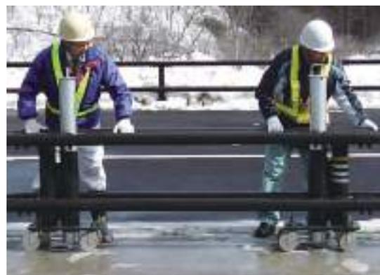
自動車専用道路の事故対応などの緊急時、キャスター(車輪)を使用することにより、人力で短時間に移動が可能な防護柵です。
