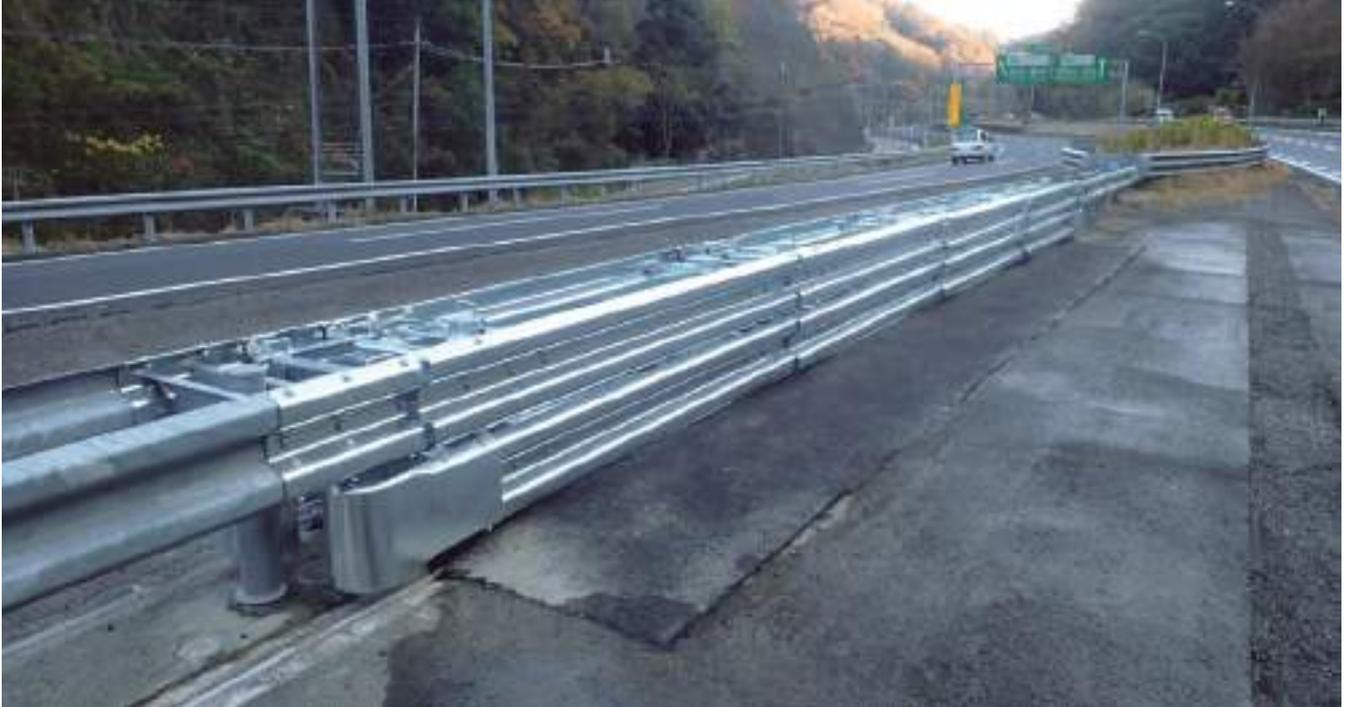
自動車専用道路の事故対応などの緊急時、クレーンや工具等を使用せずに、短時間で簡易に着脱・移動が可能な防護柵です。
