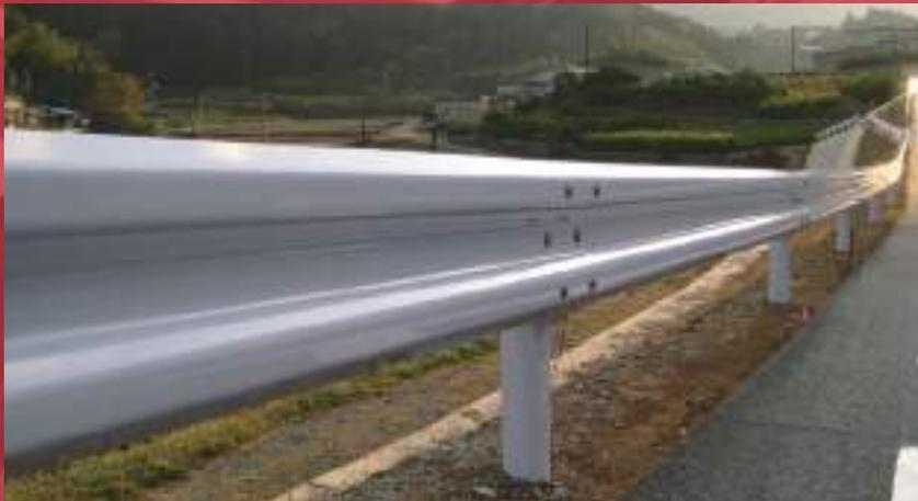
波形断面のビームが視線誘導性に優れた、最もポピュラーな車両用防護柵です。
