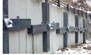
鋼製コアラ受圧板 (グラウンドアンカー用鋼製受圧板)
