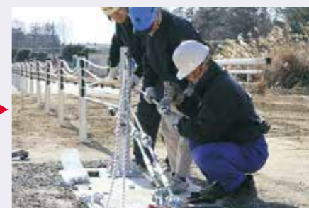
8 余分なワイヤロープをカットし、索端金具を装着、端末金具に固定します。
