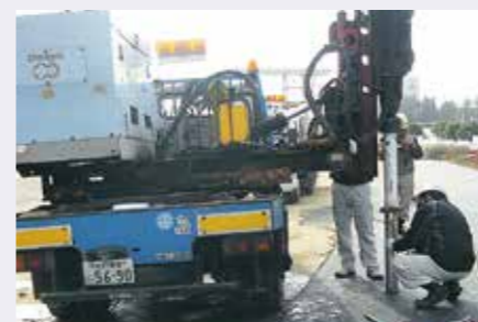
1 アスファルトをコア抜きし、エアーストライカーによりスリーブを打込みます。
