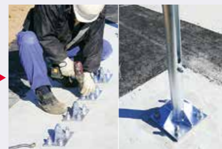
2 端末支柱、端末金具をアンカーボルトによりスリーブを打込みます。
