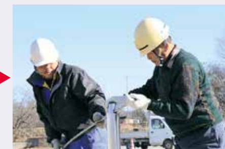
3 端末支柱用間隔材にワイヤロープを通し、端末支柱の溝にストラップと共にセットします。
