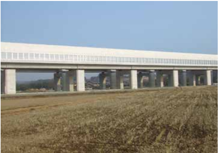
新名神高速道路 池田高架橋
