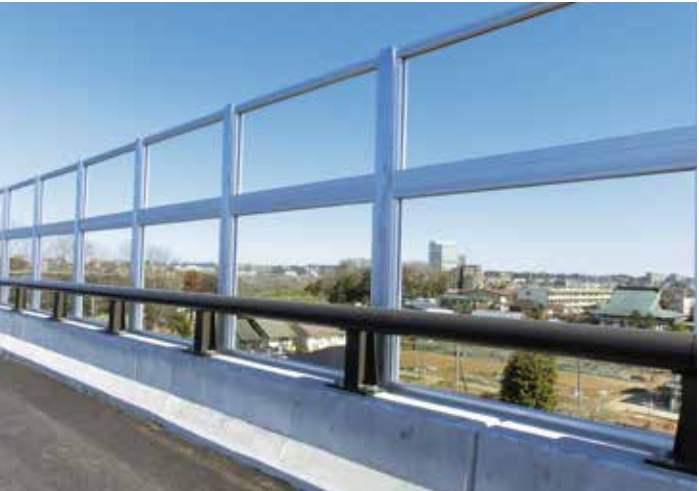
首都圏中央連絡自動車道 圏央相模川橋
