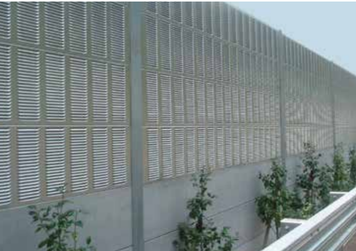
中央自動車道 八王子JCT付近
