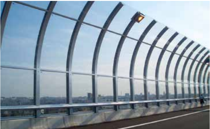
東京外環自動車道
