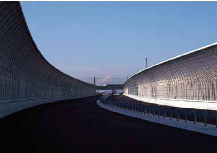
東京外環自動車道
