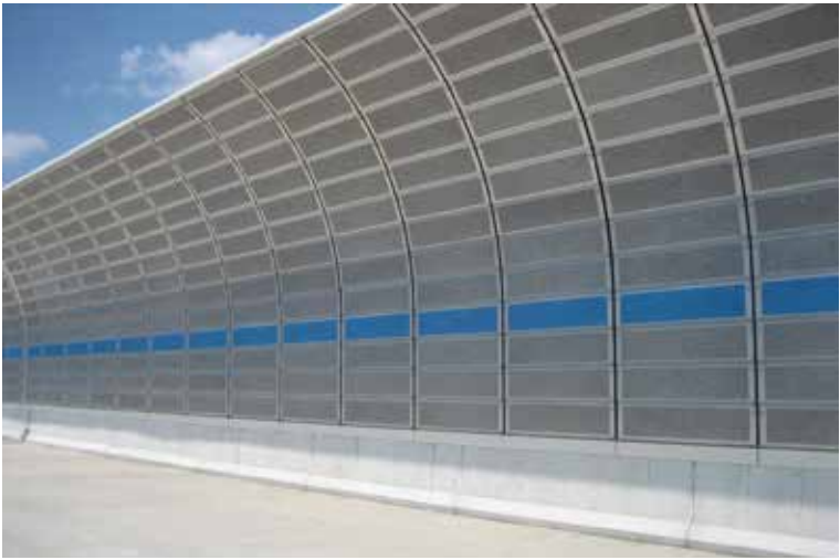
第二京阪道路 杉高架橋
