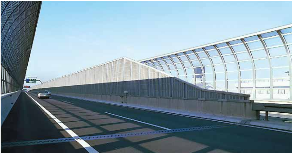
東京外環自動車道
