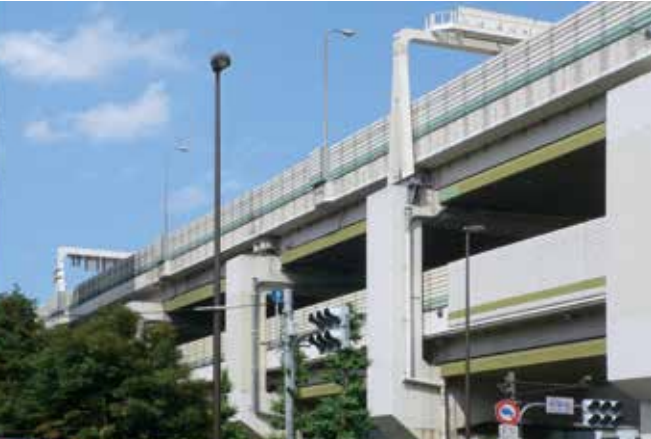
首都高速道路5号池袋線 熊野町JCT
