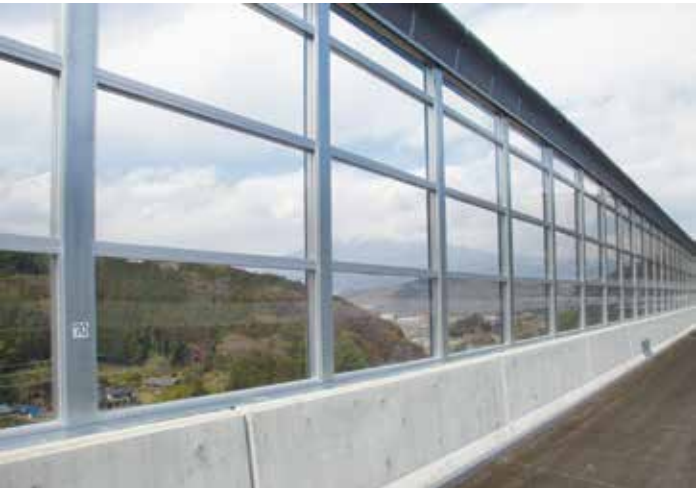
第二東名高速道路 富士川高架橋
