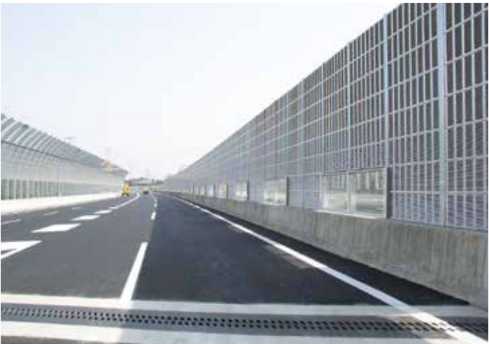
首都圏中央連絡自動車道 鶴ヶ島JCT付近
