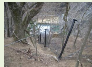
ロックホールド100 (施工事例)
