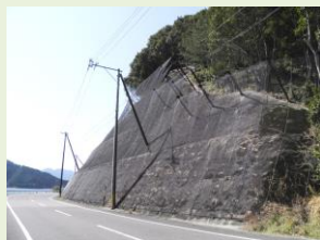
ポケット式落石防止網 (施工事例)
