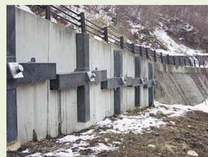
鋼製コアラ受圧板+ グラウンドアンカー
