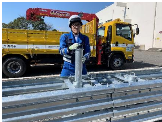
作業ステップ2：差し込み管引き抜き、回転
