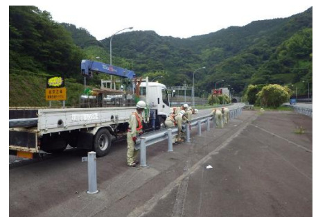
写真-3 従来の中央分離帯開口部用ガードレールの取り外し作業
