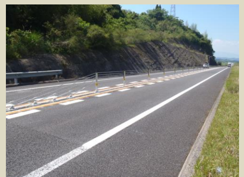
東九州自動車道
