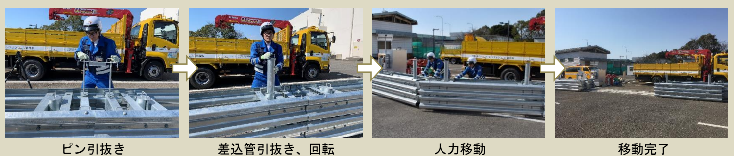
従来の中央分離帯開口部用 ガードレールの取外し作業状況
