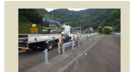
従来の中央分離帯開口部用 ガードレールの取外し作業状況
