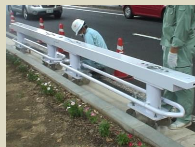
道路開放時、中央植栽帯への移動状況
