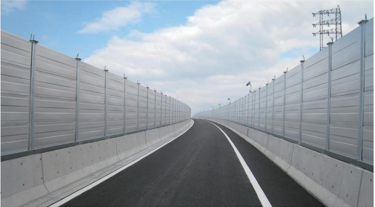
表面及び内部に多数の微細孔をあけた部材を配置し、音がこれらの微細孔を通過することにより吸音されます。
