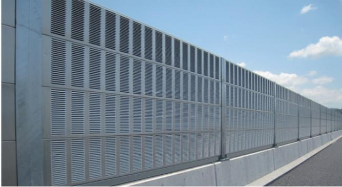
現在 道路に多く用いられている統一型防音壁は、施工方法として積み上げ方式を用いているため上下に嵌合部がある。この嵌合部の構造として、U字に曲げたアルミ材とメッキ銅板が合わさった箇所があり、その部分に水分が滞留することが問題視されている。水分の滞留により、異種金属間での電触が起こり、腐食が発生。長期間その状態が続いた結果、パネルが崩壊した例もある。
