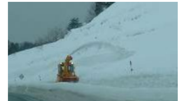
除雪時に道路法面を有効活用
