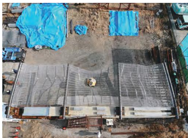
重錘捕捉（中間スパン）
