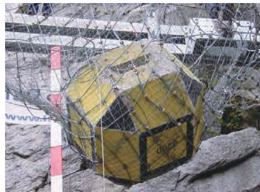
補修したネットで再度捕捉
