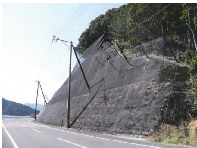
ポケット式落石防止網
