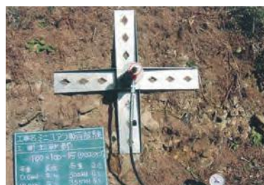
載荷試験状況(土砂部)
