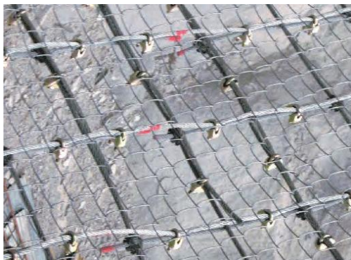
切断したネットを補修した状況
