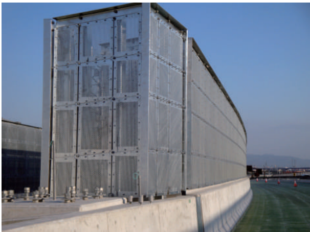
■ 京都縦貫自動車道 大山崎JCT（京都府）
