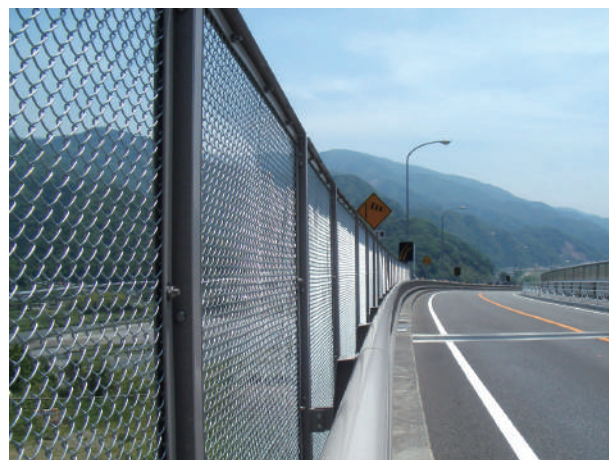
鋼製高欄・落下物防止柵
