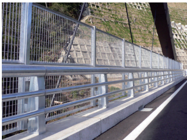
鋼製高欄・落下物防止柵
