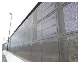
積荷転落防止柵 ...10
