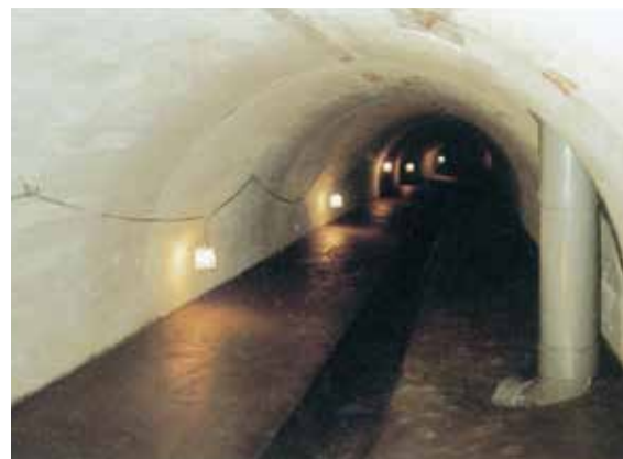
神戸市白川北汚水幹線布設工事(トンネル完成)
