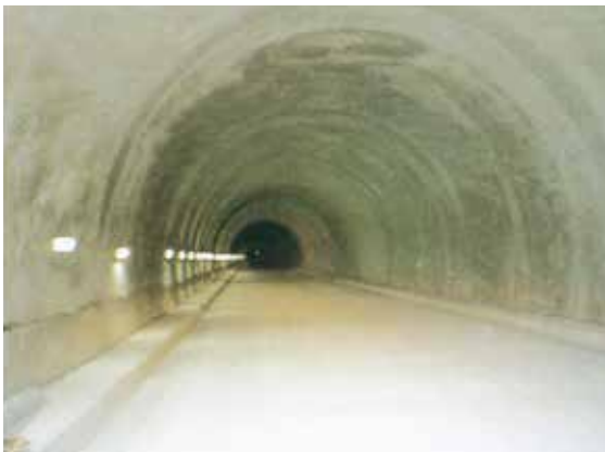
神戸市道路公社 第二新神戸トンネル舗装工事
