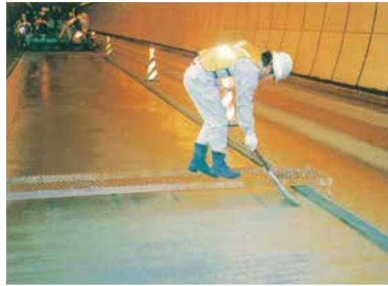
日本道路公団 今庄トンネル内舗装改良工事
