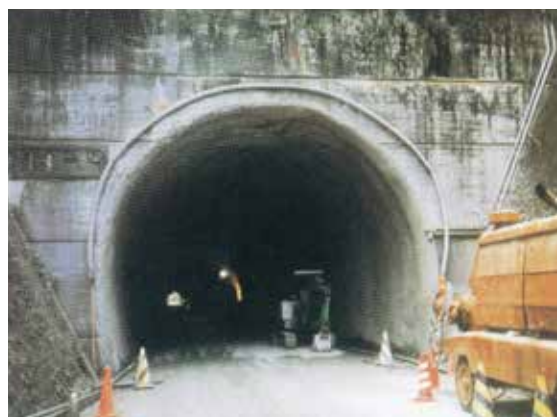
県道すさみ古座線串本トンネル補修工事
