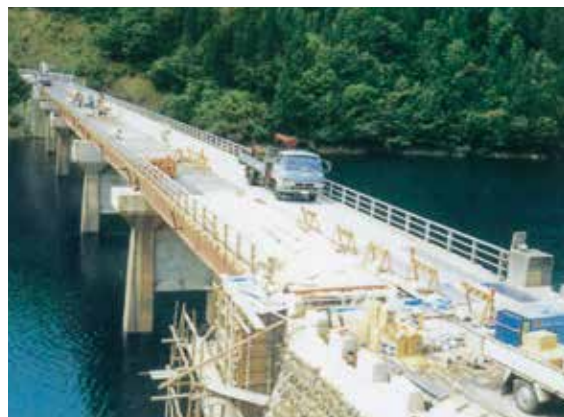
福井県林谷橋橋梁床版補修工事
