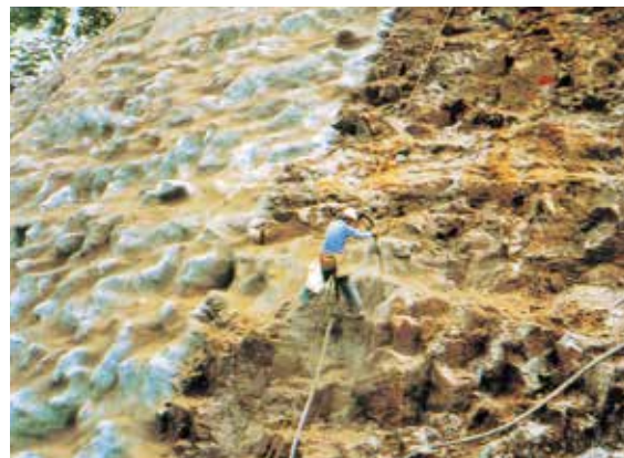
長崎県大瀬戸町道平倉三年ヶ浦線法面吹付け
