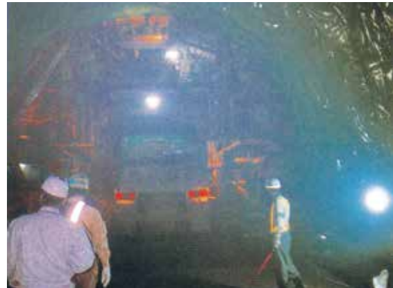
大阪府道路公社 第二阪奈トンネル工事(打込み)
