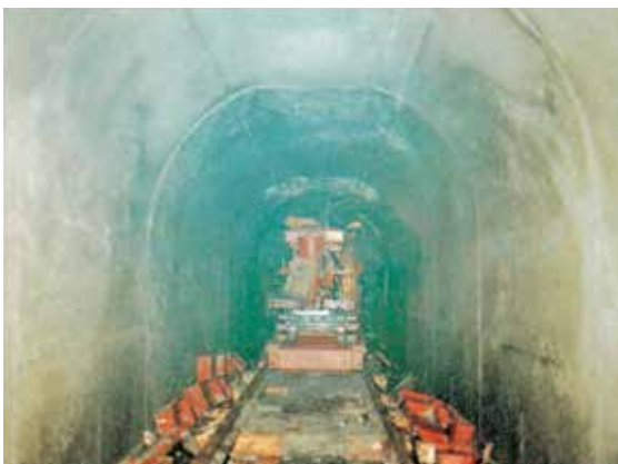
北海水力発電大野発電所導水路トンネル改修工事
