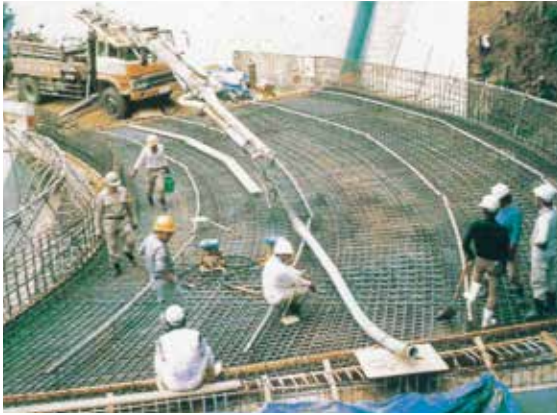
大阪府川尻3号橋床版新設工事
