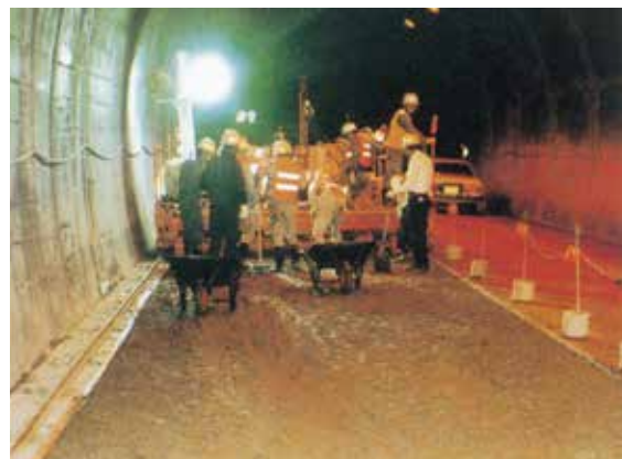
建設省倶利伽藍トンネル内舗裝修繕工事
