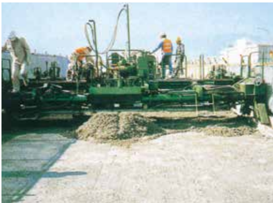
日本道路公団荒牧高架橋RC中空床版補強工事
