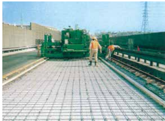
日本道路公団新澁川橋補強工事
