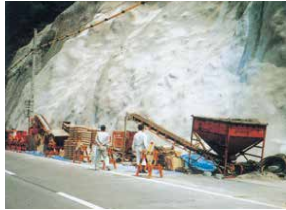
静岡県本川根川根線臨時県道災害防除工事
