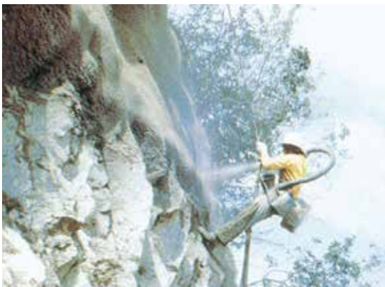
兵庫県西新宿上郡線法面吹付け
