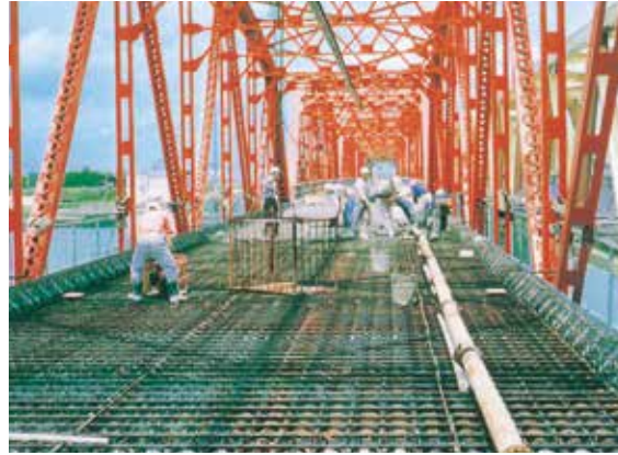
福岡県六五郎橋床版改修工事
