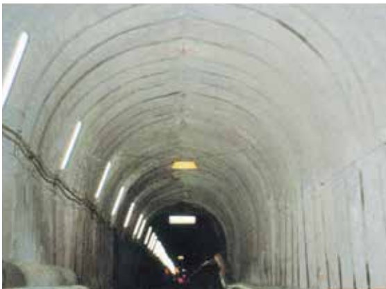
甲府市湯村山隊道配水池構造工事
