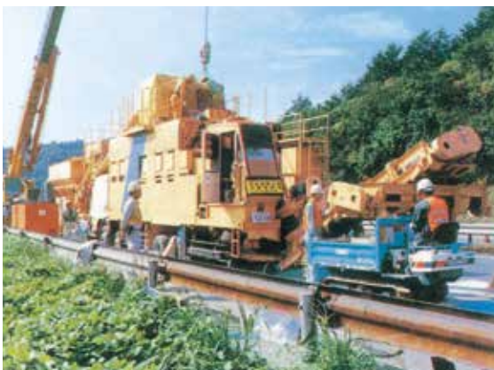
日本道路公団東名高速道路佐野川橋床版改良工事
