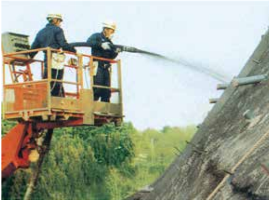
法面吹付け作業風景
