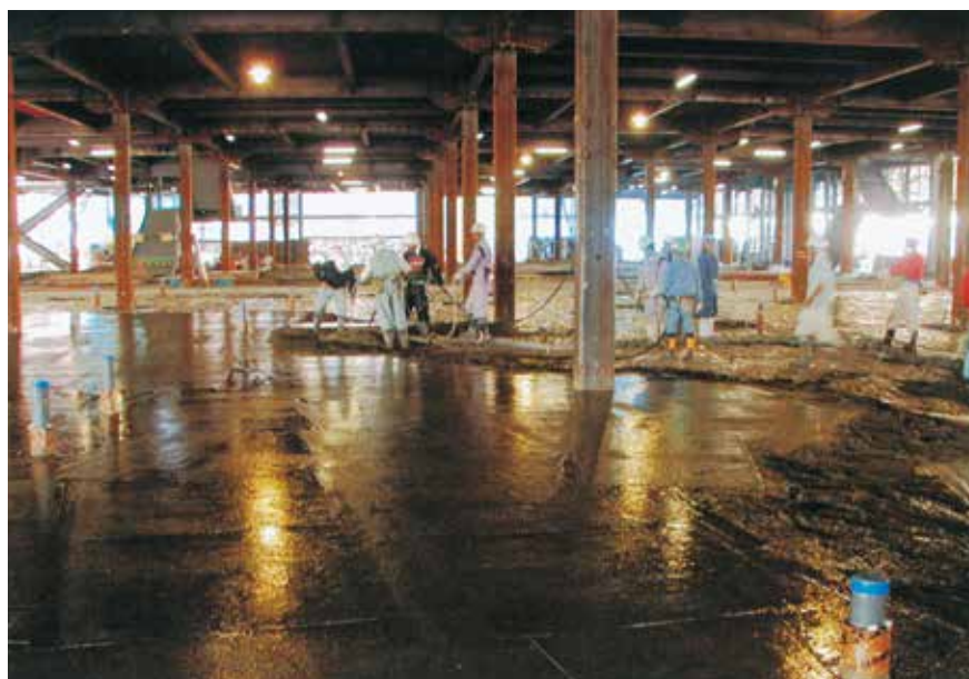
ショッピングセンター(土間打設状況)
