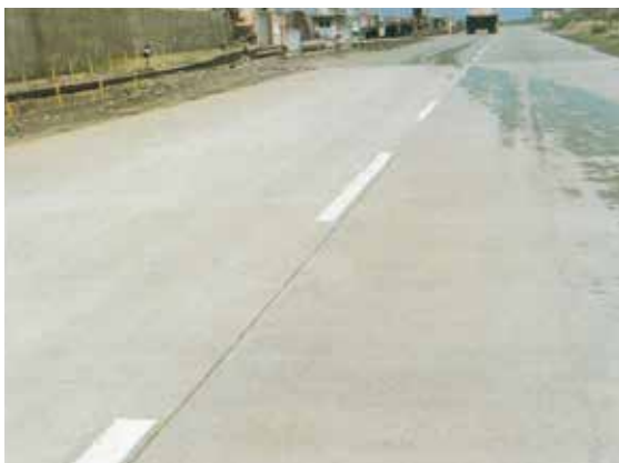
神鋼加古川製鉄所構内道路舗装
