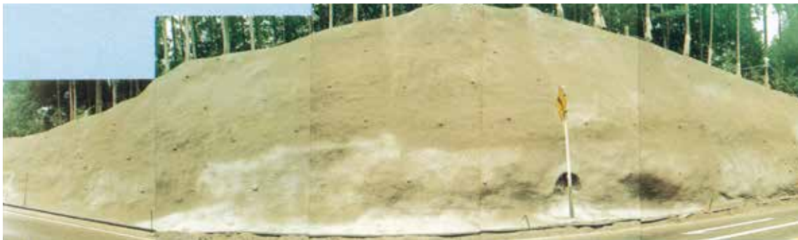
三重県国道165号線法面吹付け
