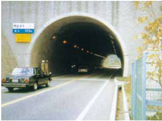
神戸市道路公社 山麓バイパス鶴越第1トンネル内舗装
