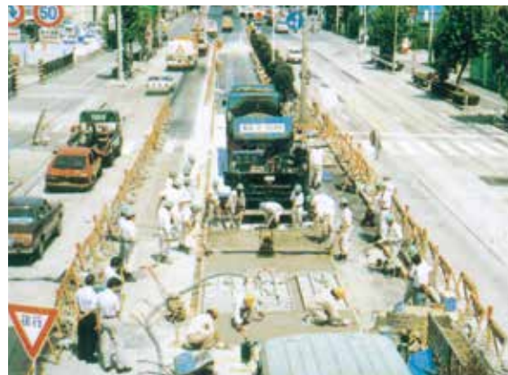
名古屋市名古屋環状線打替補修工事
