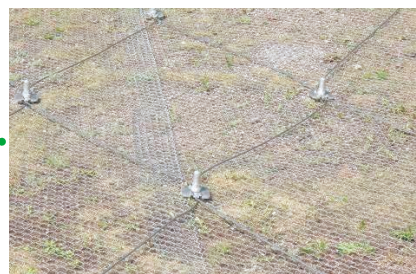
ケーブル設置工
