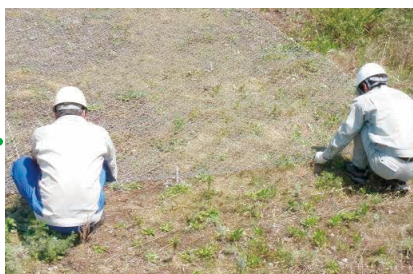
エクシードネット設置工
