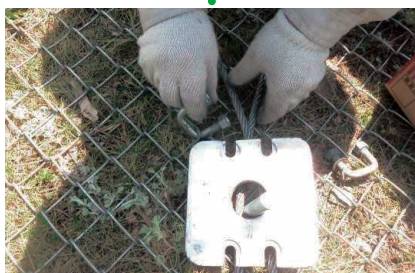
DCプレート設置工
