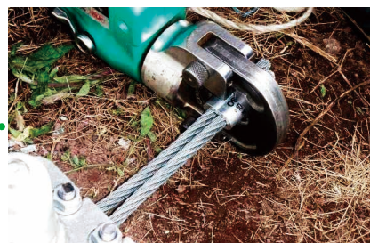
ケーブル端末処理工
