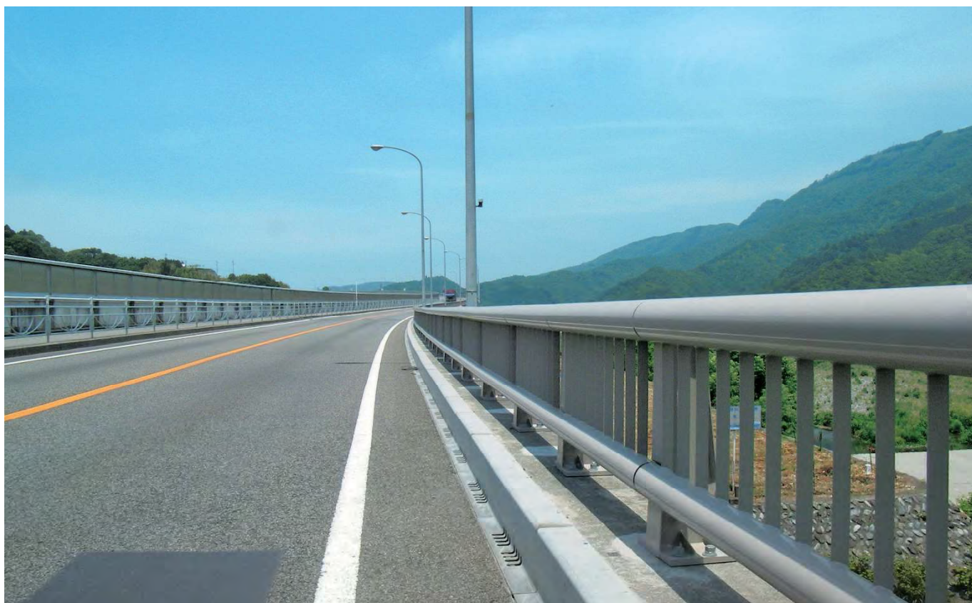
波木井高架橋（山梨県）
