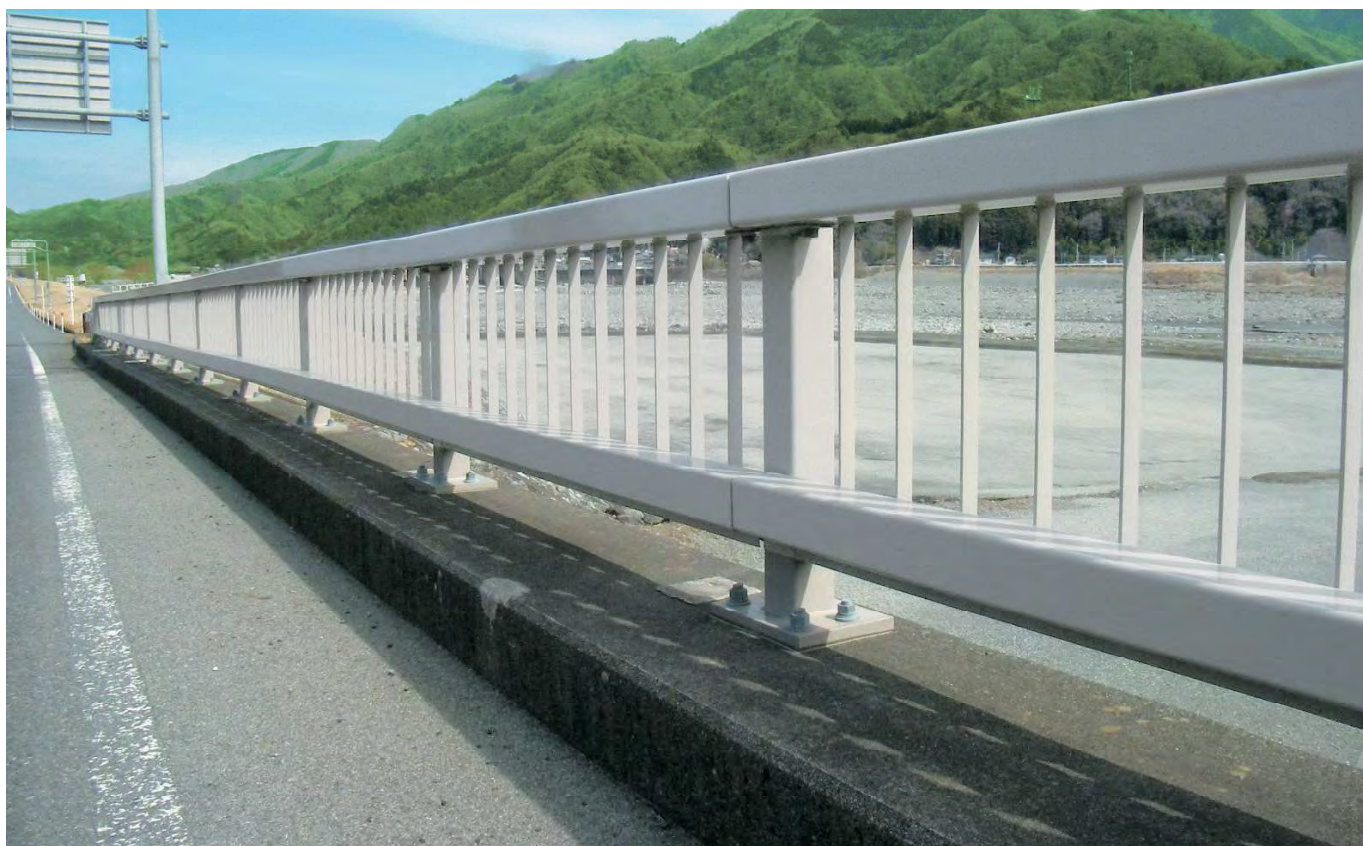
波木井第二橋（山梨県）
