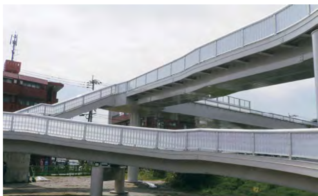
中郡歩道橋（鹿児島県）
