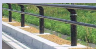
ガードパイプ
