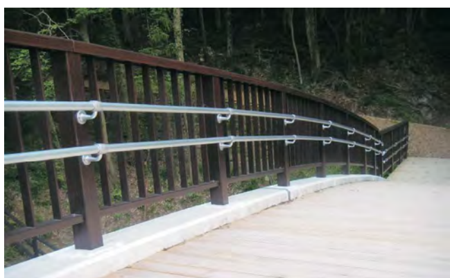
金山歩道橋（群馬県）
