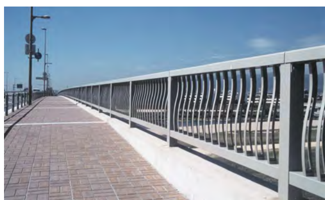
武庫川大橋（兵庫県）
