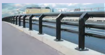
車両防護柵 歩車道境界設置
