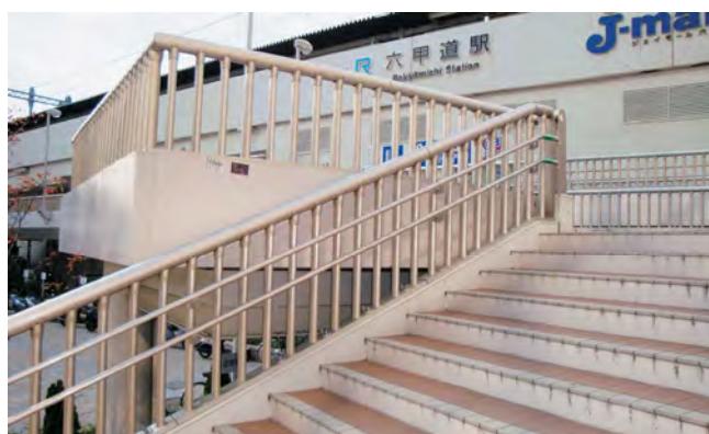
J R 六甲道駅前歩道橋（兵庫県）
