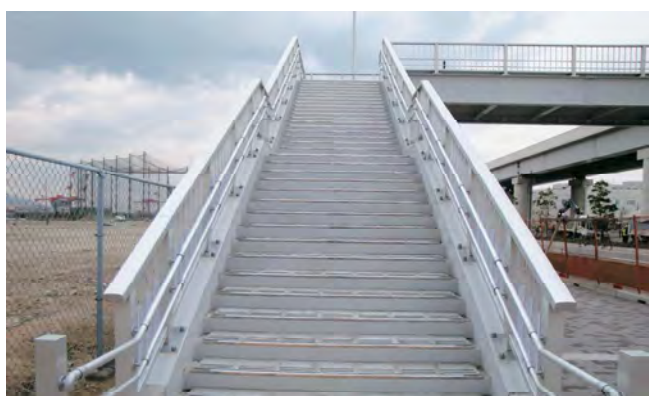
ポートアイランド南歩道橋（兵庫県）
