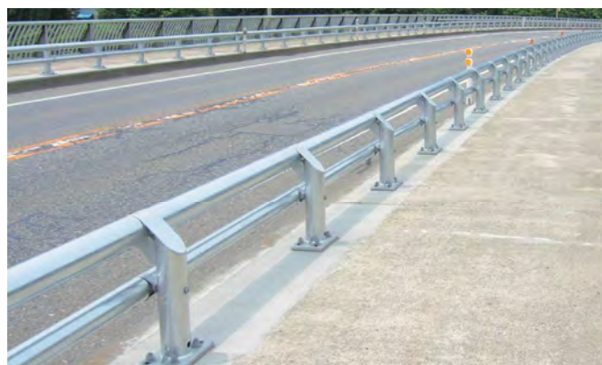
新潟国道 水明橋（新潟県）
