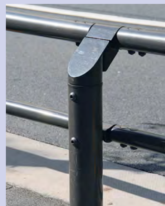
すっきりと見える天端ビームと支柱の一体化
