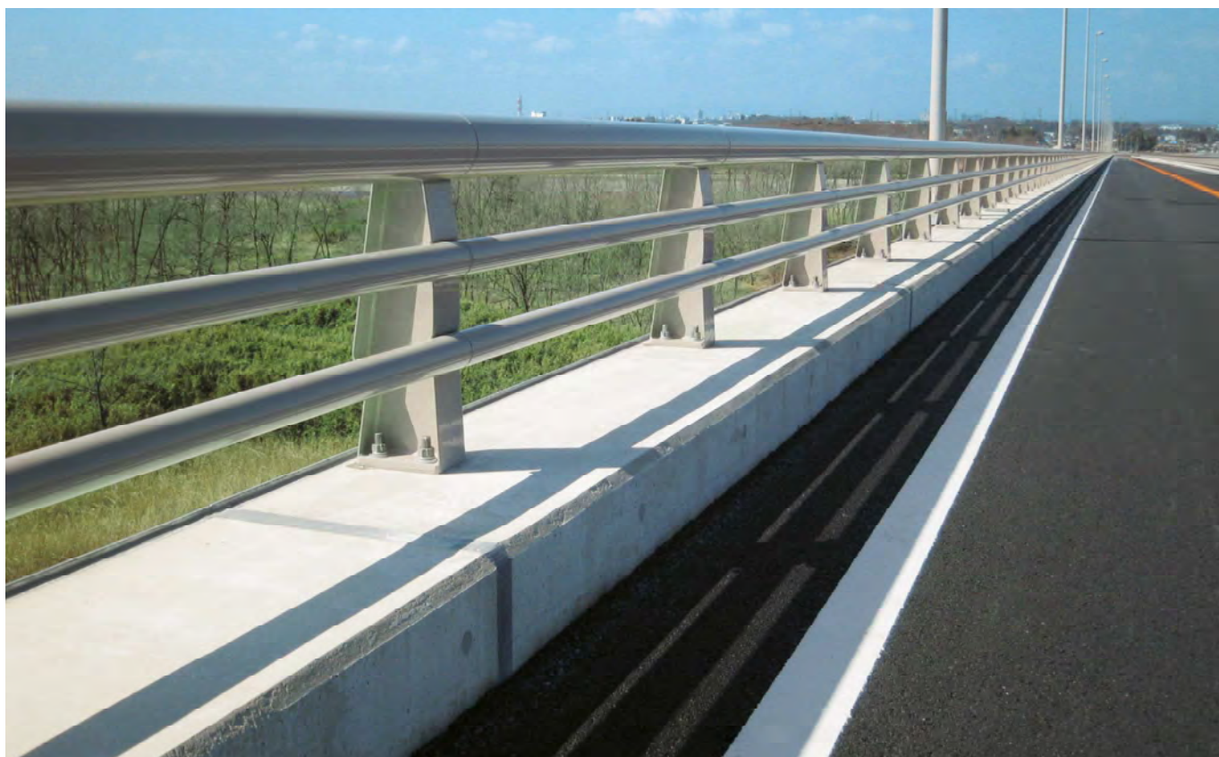
鬼怒川橋（栃木県）
