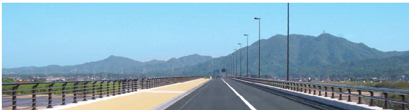
神立高架橋（島根県）
