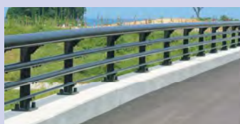
車両防護柵 路側設置
