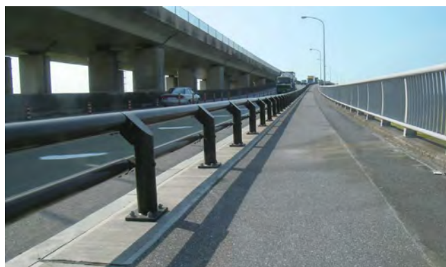
小櫃川第一橋梁（千葉県）
