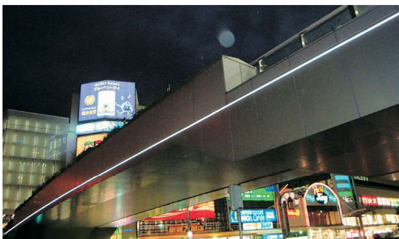
三宮駅前立体歩道橋
