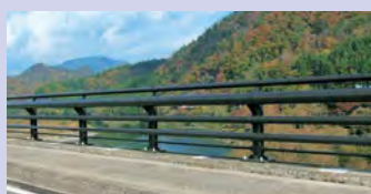
高欄兼用車両防護柵 (ツインタイプ)
